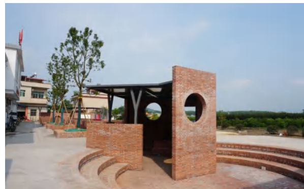
◎新龙村党建广场改造后
