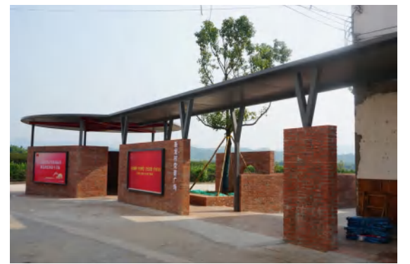
◎新龙村党建广场改造后
