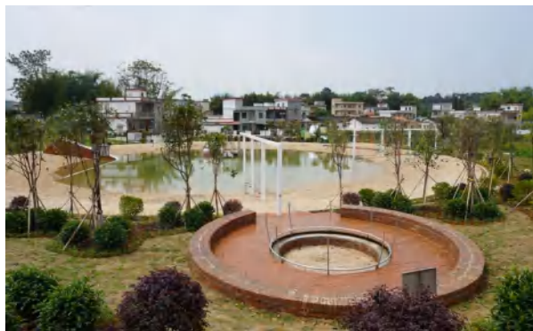
◎新龙村田园公园基础设施建设后
