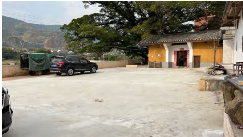
◎ 1月18日基金会对河坑村祠堂前广场硬化工程竣工验收
