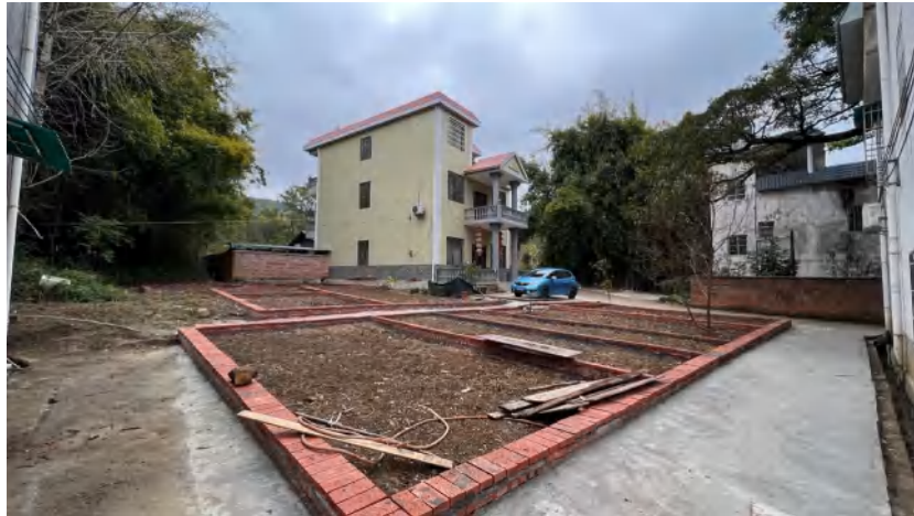
◎ 1月18日基金会对河坑村闲置空地改建菜地工程竣工验收
