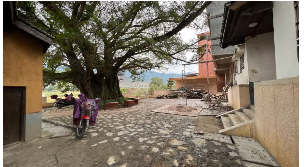
◎ 1月18日基金会对河坑村榕树下地砖填缝工程竣工验收
