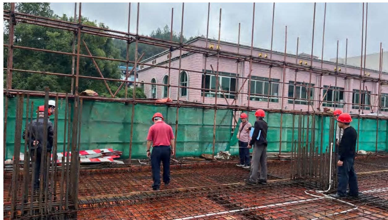
◎ 11 月 29 日基金会、仁化中学、设计单位、仁化质监站、施工单位及监理单位相关人员到仁化中学综合楼五楼进行钢筋验收
