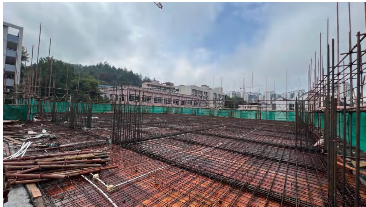
◎ 11 月 29 日仁化中学综合楼五楼钢筋验收现场
