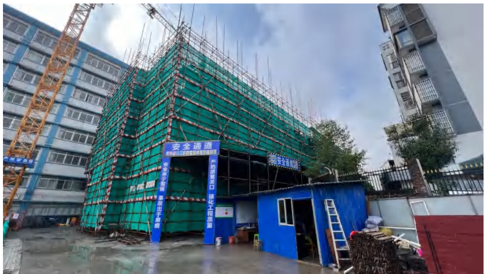
◎ 11 月 29 日仁化中学综合楼施工现场
